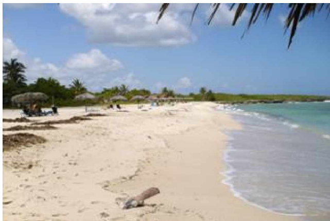
Figura 7. Playa Don Lino, luego de transcurridos ocho años de ejecutados los trabajos
